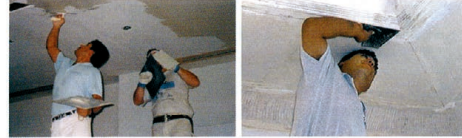
Figura 102 - Yesista: trabajo en techo.
