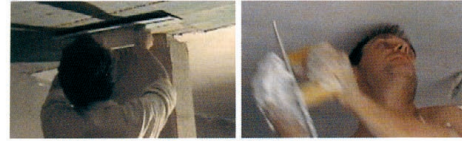
Figura 101 - Yesista: trabajo en techo.
