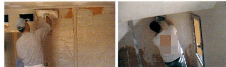
Figura 103 - Yesista: trabajo en paredes.
