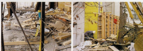
Figura 42 - Falta de orden y limpieza.
