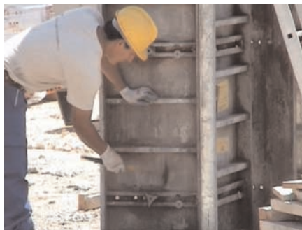
Figura 51 - Encofrador: fuerza impulsiva.
