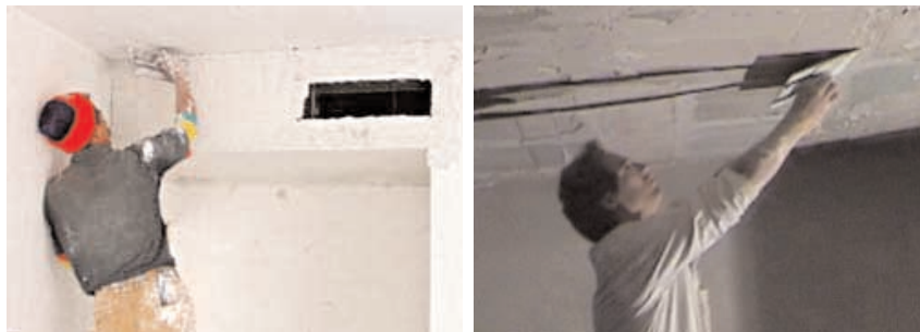
Figura 100 - Yesista: trabajo en techo.
