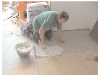
Figura 89 - Solador: trabajo de rodillas.
