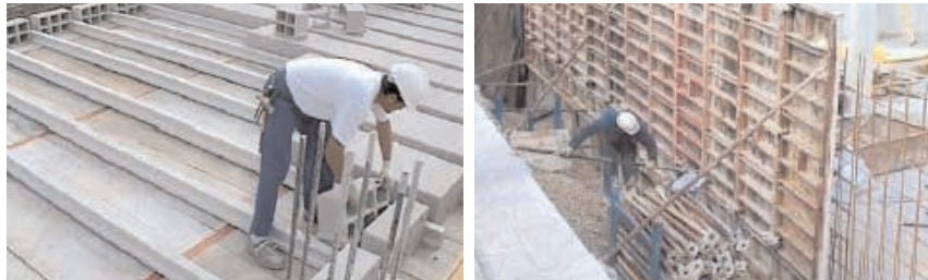
Figura 50 - Encofrador: manejo de cargas.
