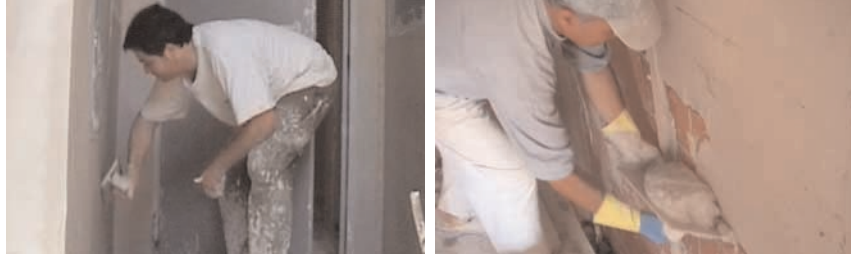
Figura 104 - Yesista: trabajo en paredes.
