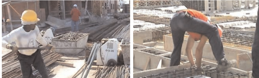
Figura 65 - Ferrallista: trabajo en superficies irregulares.
