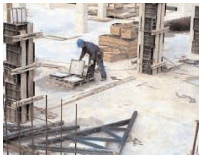
Figura 45 - Encofrador: recoger material a ras de suelo.
