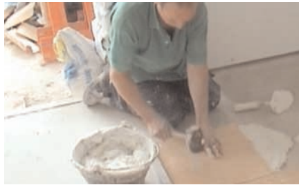
Figura 98 - Ajustar baldosas con maza de goma.
