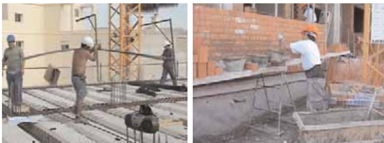
Figura 6: Tareas de manipulación manual de cargas en el sector de la construcción
