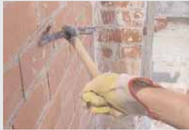
Figura 162: Agarre adecuado de la piqueta
