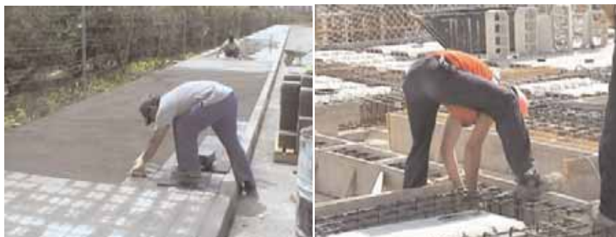
Figura 9: Posturas de trabajo forzadas en el sector de la construcción
